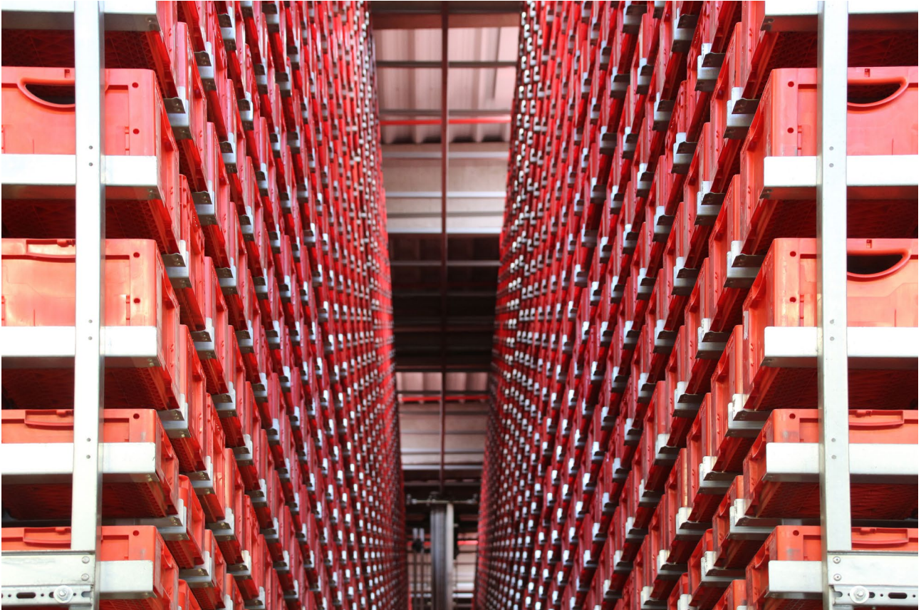
Abbildung 7: Vollautomatisches Hochregallager (Quelle: AGA Unternehmensverband)
