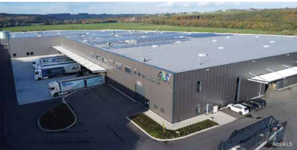
Das neue Logistikzentrum von A.L.S. in Arnberg-Voßwinkel.
