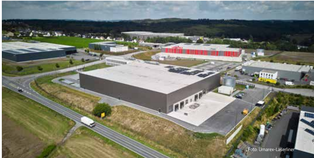
Der Neubau im Gewerbegebiet Gut Nierhof in Arnshausen.
